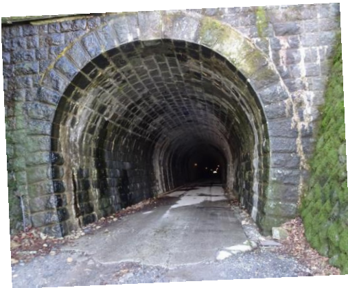
旧天城トンネル(イメージ)
