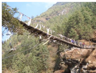
ドード・コシ(川)を渡る吊り橋
