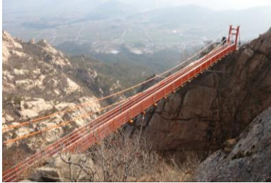
韓国一の“雲の橋”
