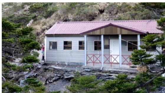
中央金鉱小屋(上)と白洋金鉱小屋(下)。共に定員 20 名ほどの小さな小屋。展望も良好です
